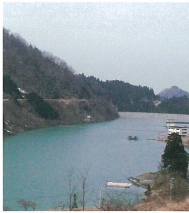
上市川第二ダム
