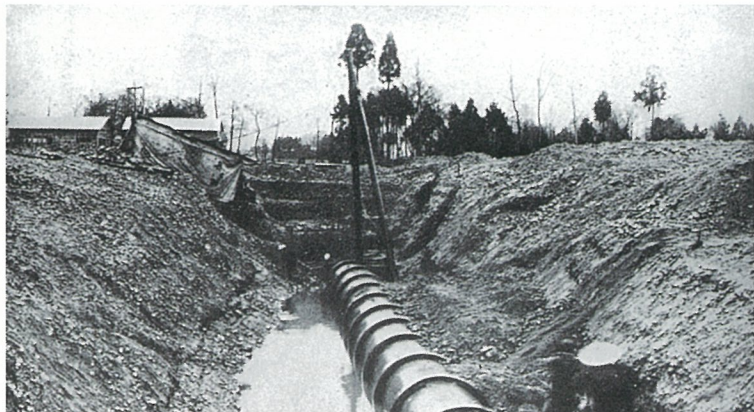
フューム管敷設の様子（『下条用水改良事業誌』所収）
