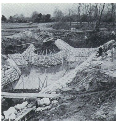
小出川最上流部工事（『白岩川右岸用排水改良事業 事業誌』所収）
