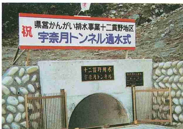
宇奈月トンネル（第2号トンネル）
