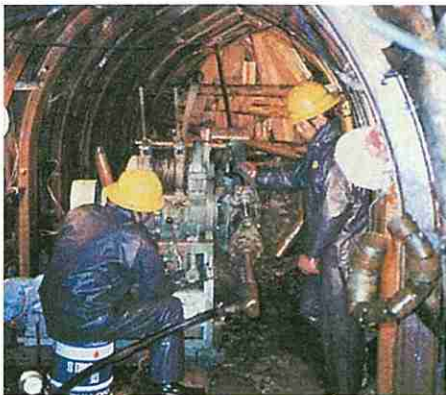
トンネル施工状況
