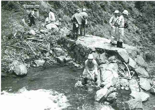
改修前の尾ノ沼谷取入口
