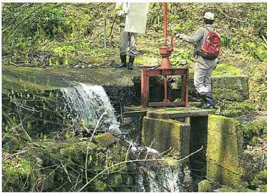
オトシ（増水時に用水路の崩壊を防ぐためこの水門を開閉した）
