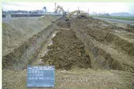
汚染土の埋め込み
