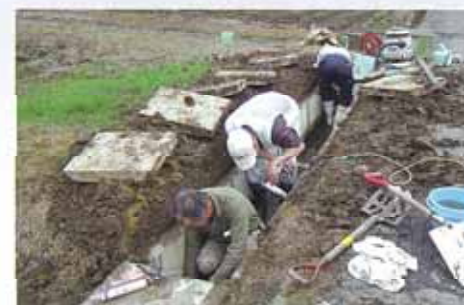
水路の目地補修
