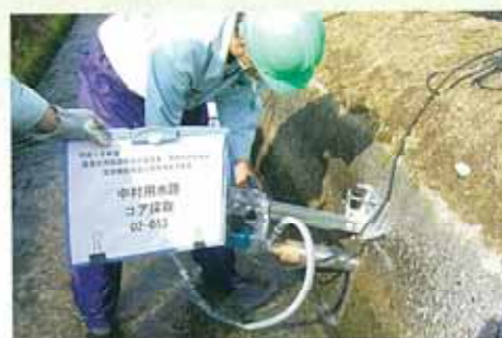
機能診断(強度確認試験)
