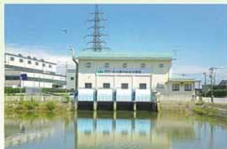
射水排水機場(中央排水機場)
