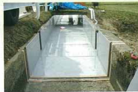
施設の長寿命化を図るための補強
