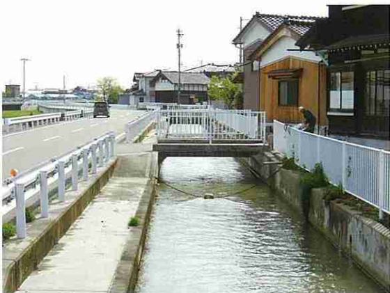
改修後の下八ヶ用水路（高岡市手洗野地内）
