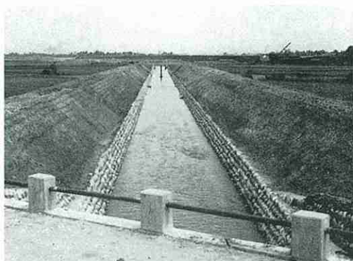
広谷川排水路竣工後の下流部（『県営小矢部川下流左岸用排水改良事業事業誌』より）
