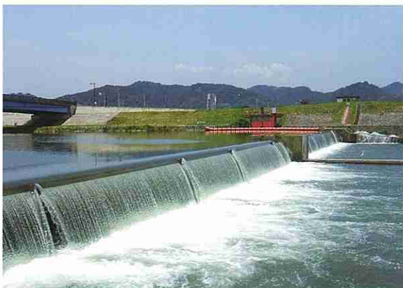
三日市頭首工（高岡市福岡町三日市地内）
