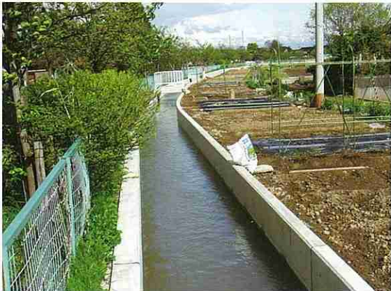
改修後の佐加野用水路（高岡市佐加野地内）
