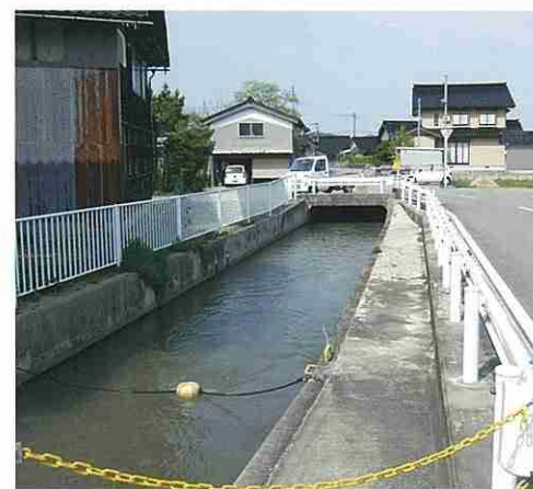
暗渠化した水路（高岡市手洗野地内）
