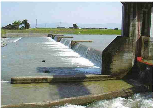
五位庄頭首工（小矢部市田川地内）
