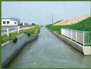
合口幹線用水路
