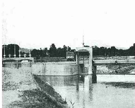
合口幹線水路竣工後（中部幹線排水場）（『県営小矢部川下流左岸用排水改良事業事業誌』より）
