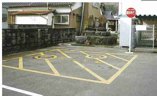
防火水槽（高岡市石堤地内）
