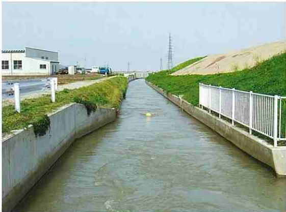
合口幹線用水路（高岡市福岡町三日市地内）
