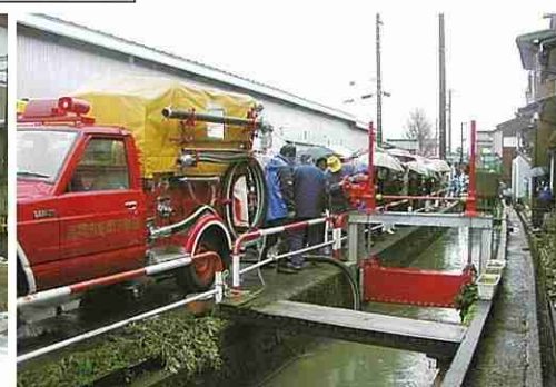
防火用水門（高岡市守護町地内）
