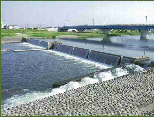
三日市頭首工
