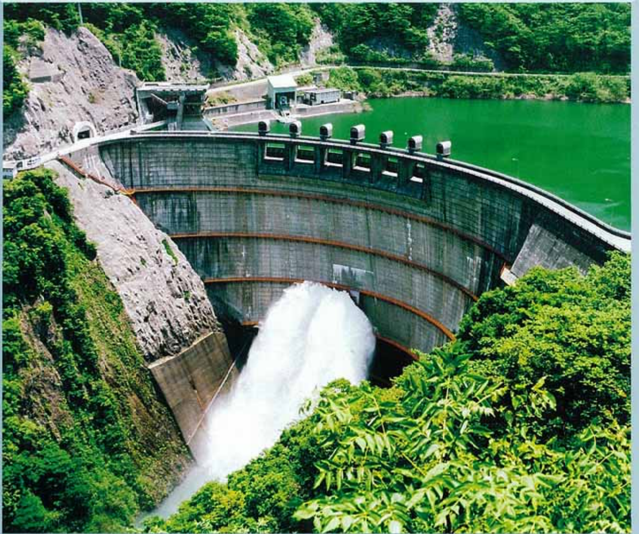
国営農業水利事業 小矢部川地区 刀利ダム(コンクリートアーチ式ダム)
