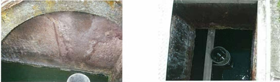
嫌気性ろ床槽や接触ばっ気槽等は、硫化水素により腐食が進行し骨材が露出していることがあります。特に液相部と気相部との境目が著しく腐食が進行しています。原因は、空气中的硫化水素が好気性の細菌（硫黄酸化細菌）により酸化した硫酸によるものです。
