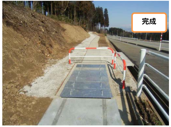
外北地区 外輪野用水路蓋掛け水路工 一部完成
