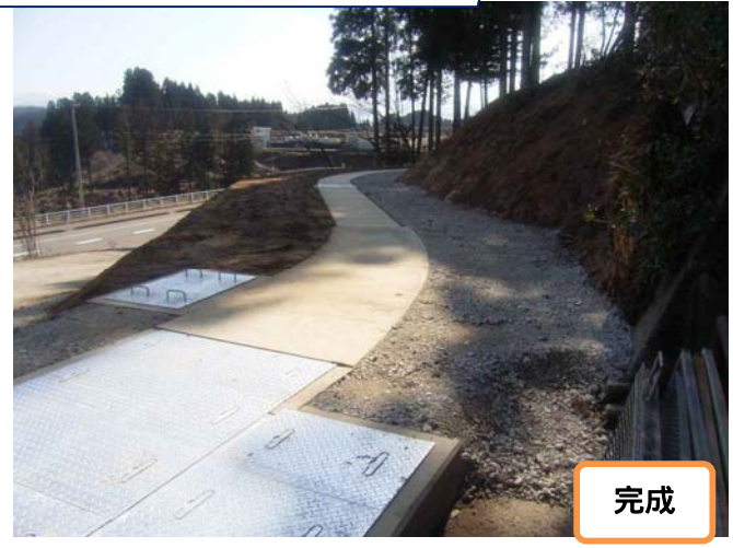
外北地区 外輪野用水路蓋掛け水路工 一部完成
