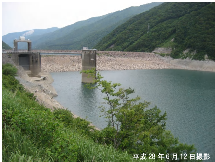
御母衣ダム (有効貯水量3億3千万 m^3 ・満水位65m)
