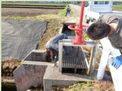
水門(簡易水門)等の点検作業 【定期点検】
