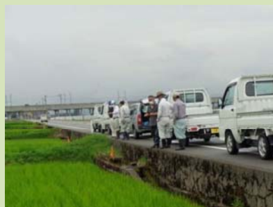
用水路の点検作業【定期点検】
