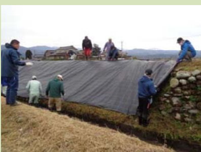
防草シートの設置作業
