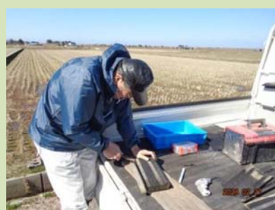
劣化した簡易水門の補修作業
