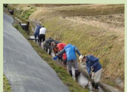
水路の泥上げ(江ざらい)
