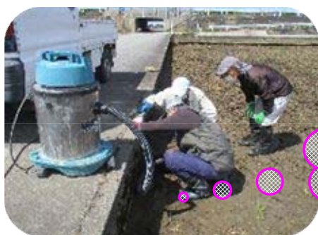
排水パイプの目詰まり清掃(4月)
