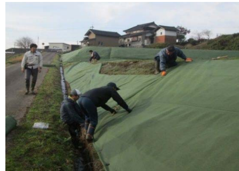
防草シートの敷設
