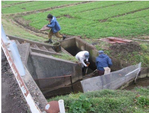
パイプラインの泥上げ
