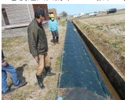
⑨農道法面防草シート張り工事
