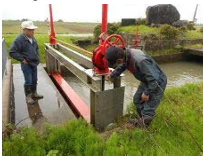
③施設の機能診断の様子
