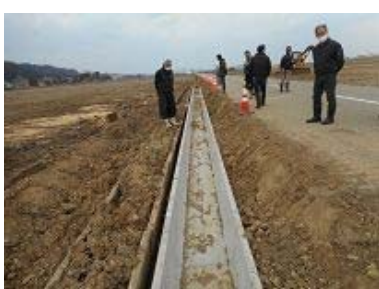
⑧U字フリューム更新工事
