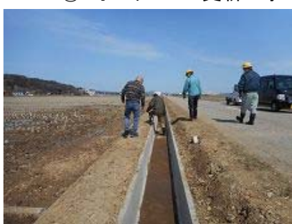
⑧U字フリューム更新工事
