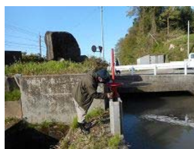
③施設の機能診断の様子
