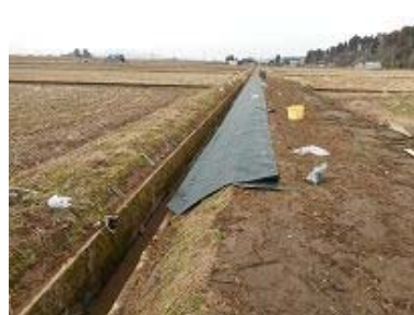
⑨農道法面防草シート張り工事
