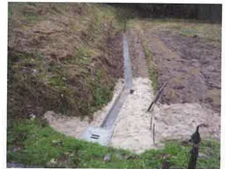
ため池（大覚口）下の水路補修（12月15日）
