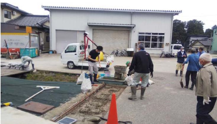
👉 14 班 集落道の路肩補修（4月4日）
