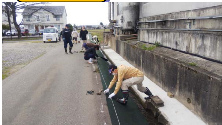
16班用水路で除草幕の設置（4月4日）
