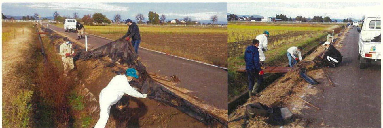
③ 老朽化した防草シートの撤去
