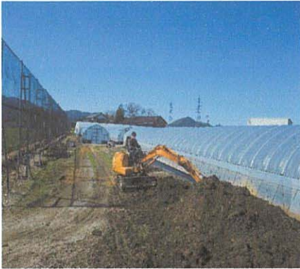
3/19 用排水路の泥処理
