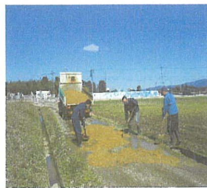
3/19、(道路愛護)農道の 碎石補充作業
