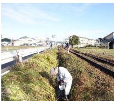
水路の草刈作業 11/15
