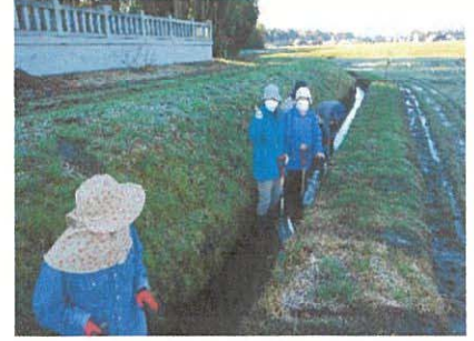
3/19 江浚え 水路泥上げ
