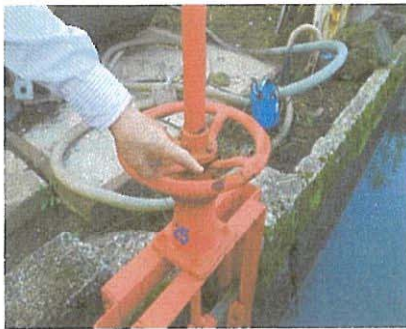
農道・水路・水門点検 9/11
