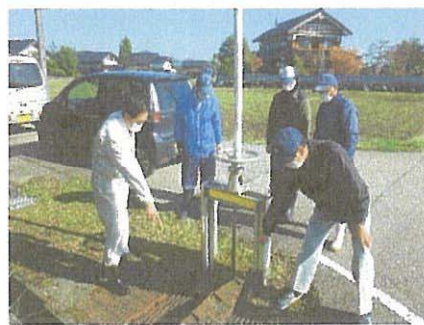
水門等の点検・診断 4/17
