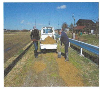
3/19 道路愛護 砕石均し
