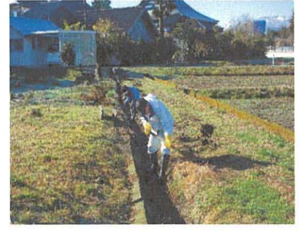
3/19 江浚え 水路泥上げ
