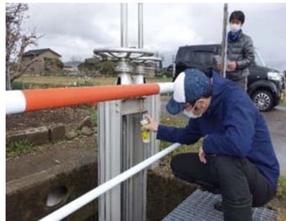
水門等の点検・診断 4/19
