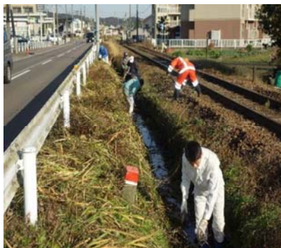
水路の泥上げ作業 11/15
