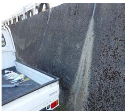
水路コンクリート補修 10/21
