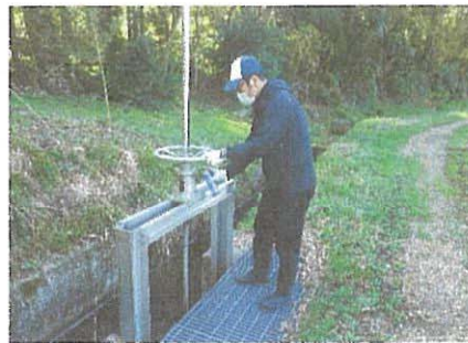
水路の点検作業 4/8
