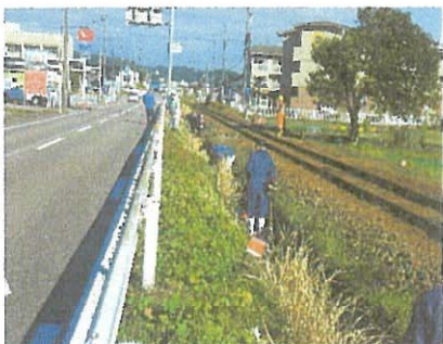
水路の草刈作業 11/6
