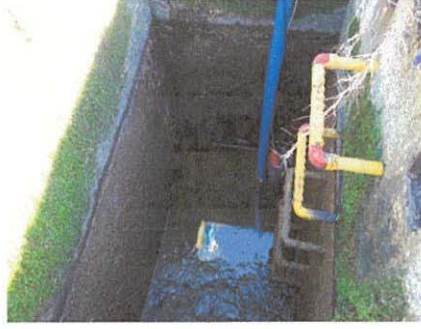
3/19 江浚え 溜柵泥上げ
