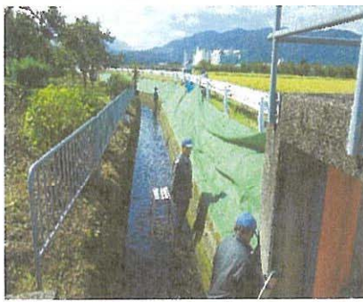
東石黒用水路法面作業 10/11
