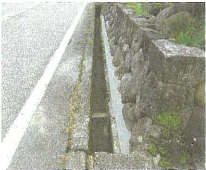
水路コンクリート補修 10/21
