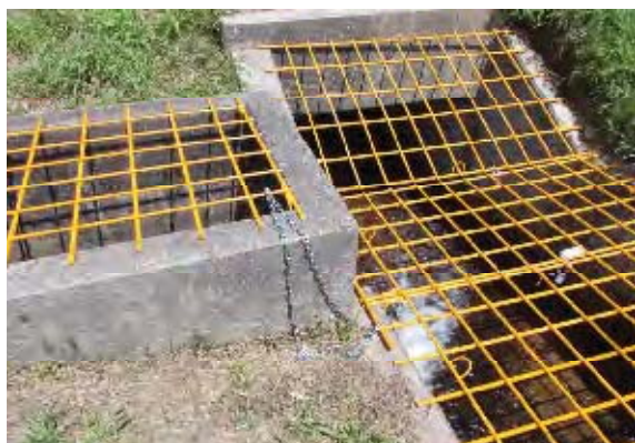
水橋 高堂地内に設置
