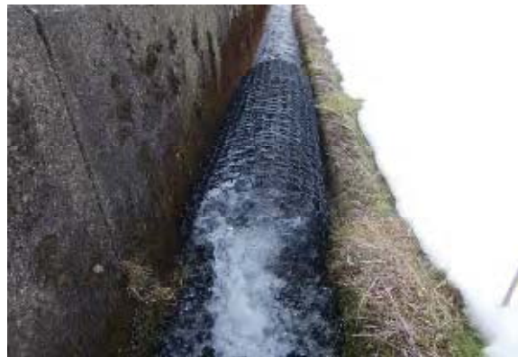
用水路設置状況
