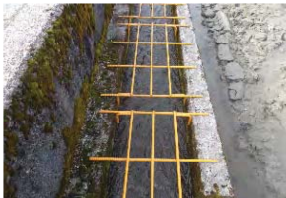
用水路設置状況
