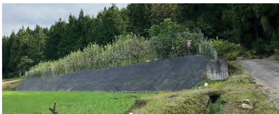
図: 防草シート G2260 の施工現場（富山県黒部市）※施工時期 20 年以上前
