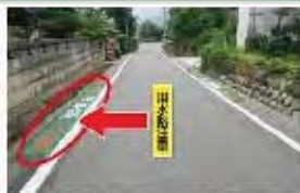
路面標示による注意喚起
