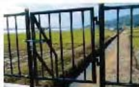
転落防止柵 (片開き門扉)
