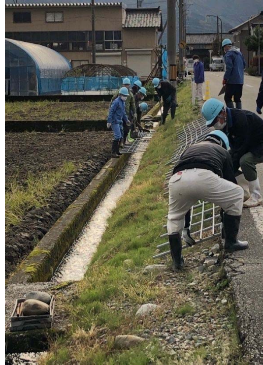
共同。水路の転落防止網設置
