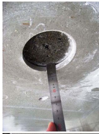
コア抜きによる浮きの確認
