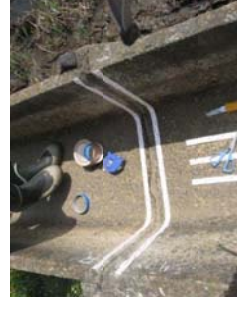
③養生テープの貼付け 養生(マスキング)テープを貼付け
