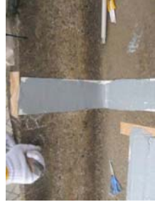
⑥表面の成形 ヘラを使い表面を成形
