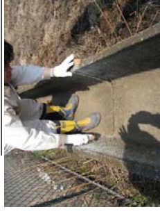
①補修箇所の清掃 ワイヤブラシで泥やコケの清掃
