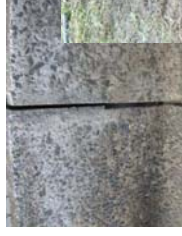
①補修箇所の清掃 ワイヤブラシで泥やコケの清掃
