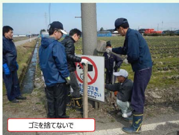
環境保全看板の設置
