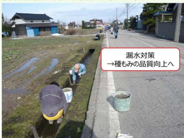
目地詰めによる用排水路補修
