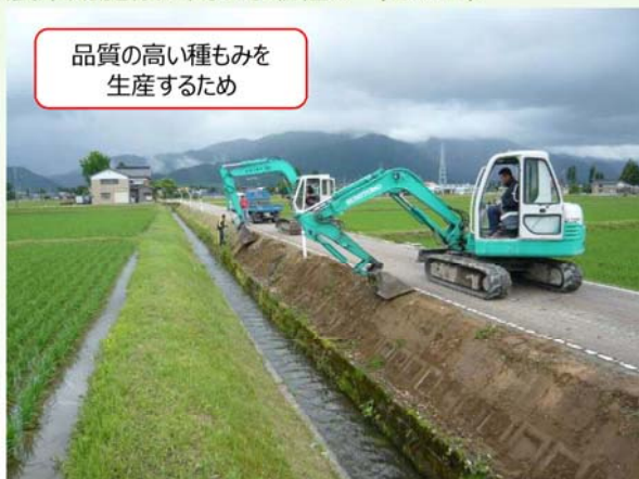
センチピードグラス張付前の法面整形
