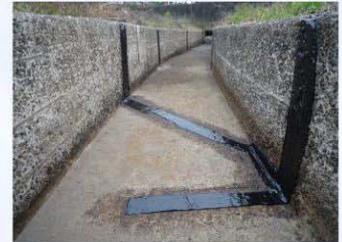
高強度の樹脂モルタルを水練りし、目地に詰めるだけの簡単作業です。欠損部や桧の補修などにも、大勢で気軽に補修作業が進みます。
