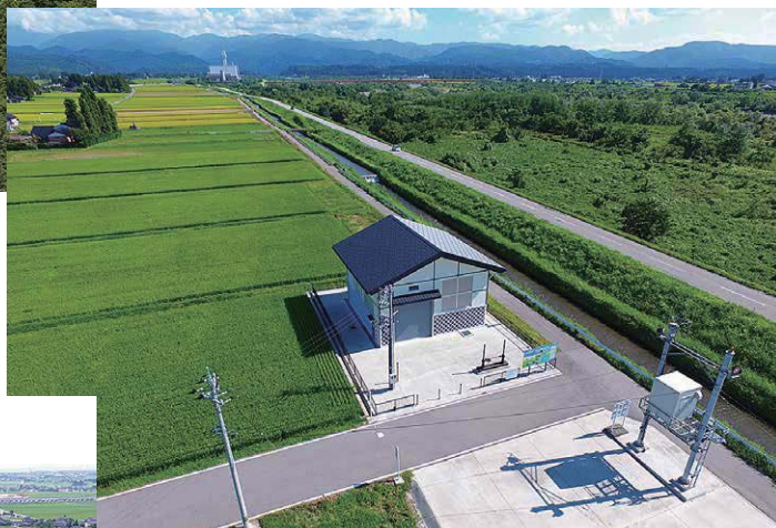
常東合口幹線発電所（富山県立山町）
