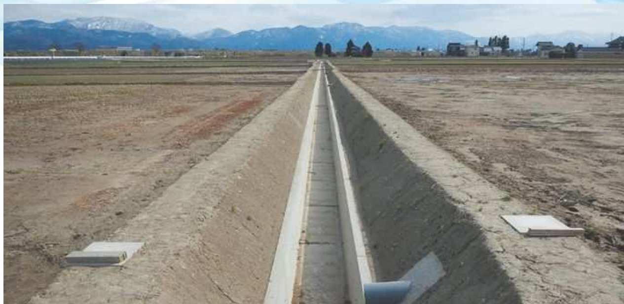
基盤整備促進事業 庄下東部2期地区 庄下4号排水路第1工区整備工事
