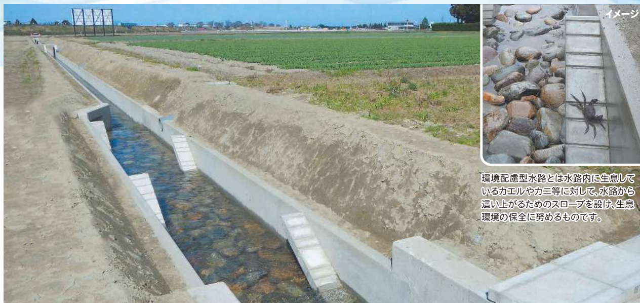
基盤整備促進事業 庄下東部2期地区 庄下4号排水路第3工区整備工事(環境配慮型排水路)
