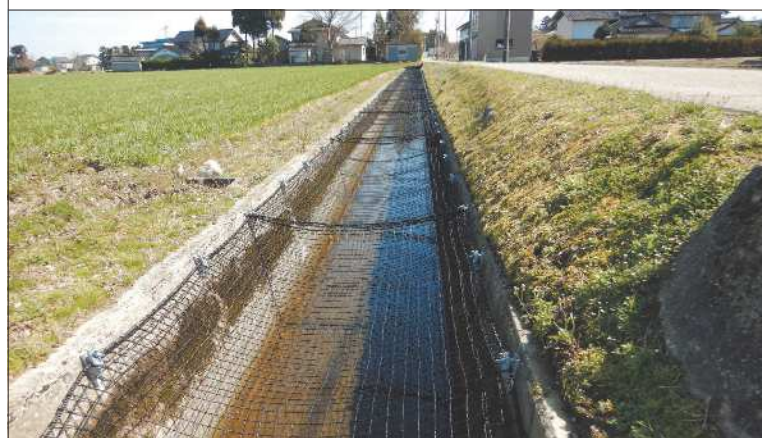
令和4年度県単独農業農村整備事業祖泉地区にて施工
