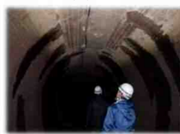
トンネル内部
