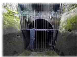
トンネル入口
